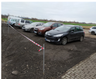
Bakov Tyršova - úprava parkoviště
